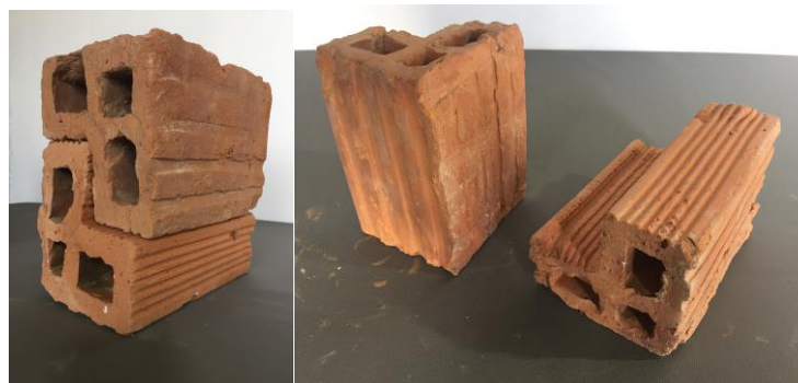
Figura 5 - Blocos cerâmicos com seção transversal em “L”.
